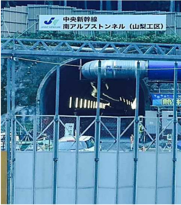
(上は南アルプストンネル山梨県側試掘口)
