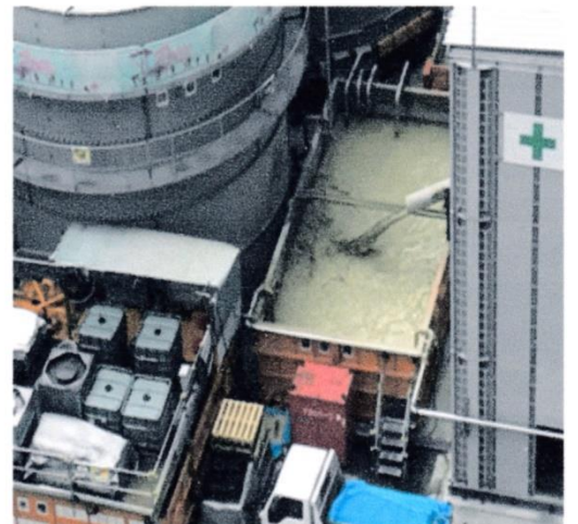
写真; 敷地南部の処理プラントで排出された汚染水。湧出地下水等の工事排水は濁水処理後に下水道に排出されています。
