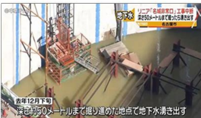
リニア「非常口」工事 地下水で掘削作業中断 名古屋・中区
