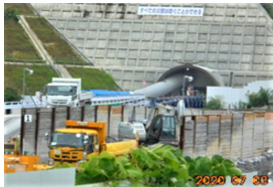
西尾非常口 保守基地線トンネル
