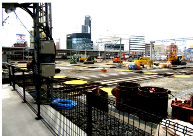
図 名古屋駅前工事現場（2018年3月4日撮影）
