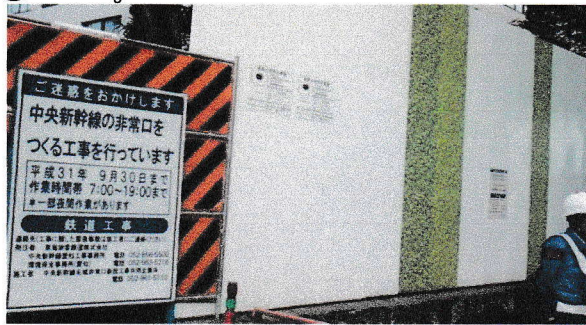
図2. 非常口工事現場を示す掲示板
