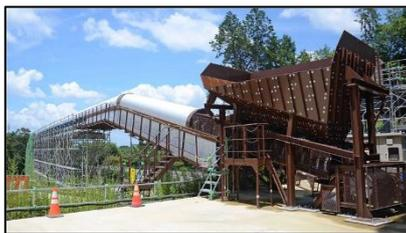
第一中京圏トンネル工事大針工区は多治見市の大針町と北小木町に、延長約5kmの本線トンネルと、約1kmの非常口トンネル(斜坑)を19年3月～26年6月の工期で建設する計画。大針工区ヤードでは国道248号に沿って工事現場から数百m離れた処分場まで高さ20メートルのベルトコンベヤーを設置、斜坑口から発生土を載せて運び出し、一度下ろして検査して、基準を満たした健全土は次のベルトコンベヤーに載せ、248号国道下の通路を通して、畑佐興業(愛知県春日井市)の残土処分場に搬出している。
